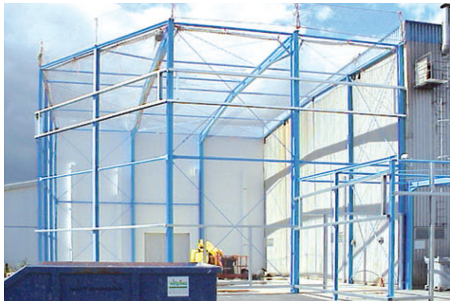
Erweiterungsbau für Ausrüstungsanlagen in Bersenbrück im Jahre 2004
